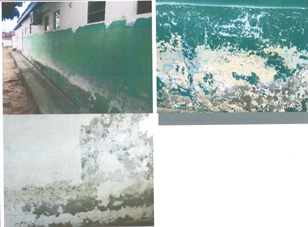
Preparação da superfície para receber pintura.
