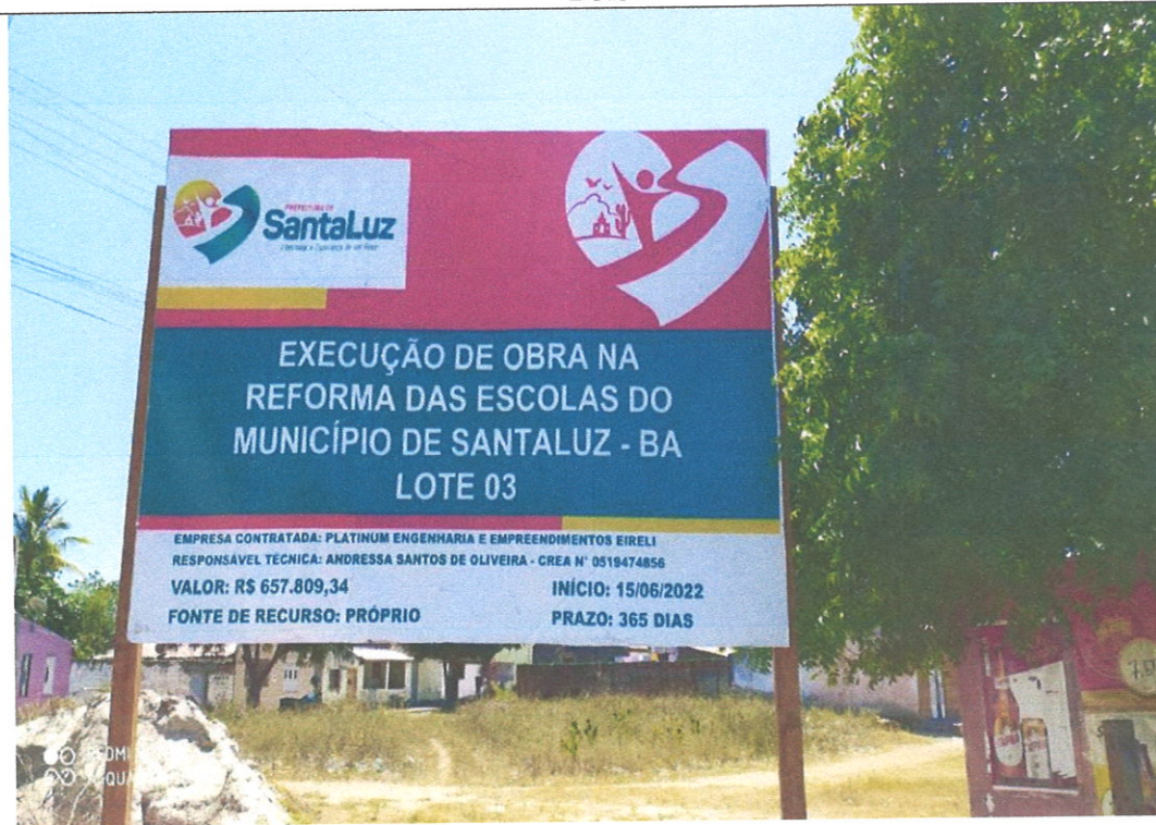
Placa de obra lote 3
