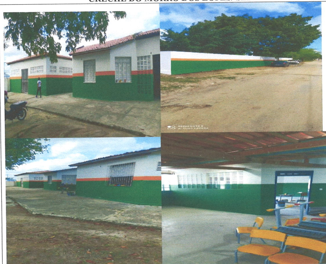
Execução de pintura.
